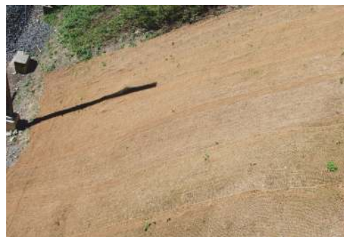
Pose du Sifor® Géofilets en coco.
